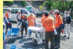
▲岩手県大槌町への職員派遣・ボランティアバスの運行
