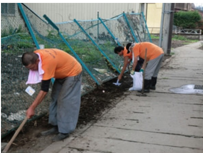
津波によってなぎ倒されたフェンス脇の清掃
