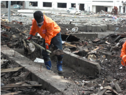
ガレキの撤去作業中
